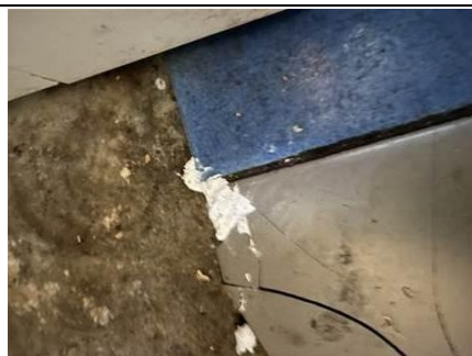
Photo n° PhA007 Localisation : Cuisine Ouvrage : 5 - Planchers et planchers techniques - Revêtements de sols Partie d'ouvrage : Dalle de sol Description : Carrelage et colle
