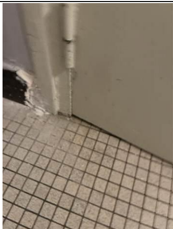
Photo n° PhA014 Localisation : sdw-wc Ouvrage : 3 - Parois verticales intérieures - Revêtements de murs, poteaux, cloisons, gaines, coffres Partie d'ouvrage : Plinthe Description : Colle de faïence
